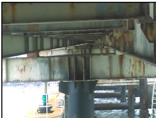
VISTA DE LAS ESTRUCTURAS ANTES DEL MANTENIMIENTO (ENERO 2017)
