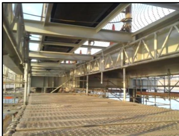
VISTA DE LAS ESTRUCTURAS DESPUÉS DEL MANTENIMIENTO (MARZO 2017)
